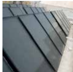
Piscina Municipal, La Oliva (Las Palmas) 75 Placas solares de alto rendimiento. Climatización piscina cubierta.
